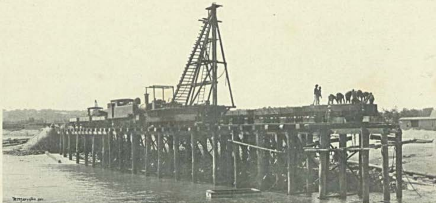
Caes Gorjão. — Descarga de um comboio de pedra depois do cravamento da estacaria
