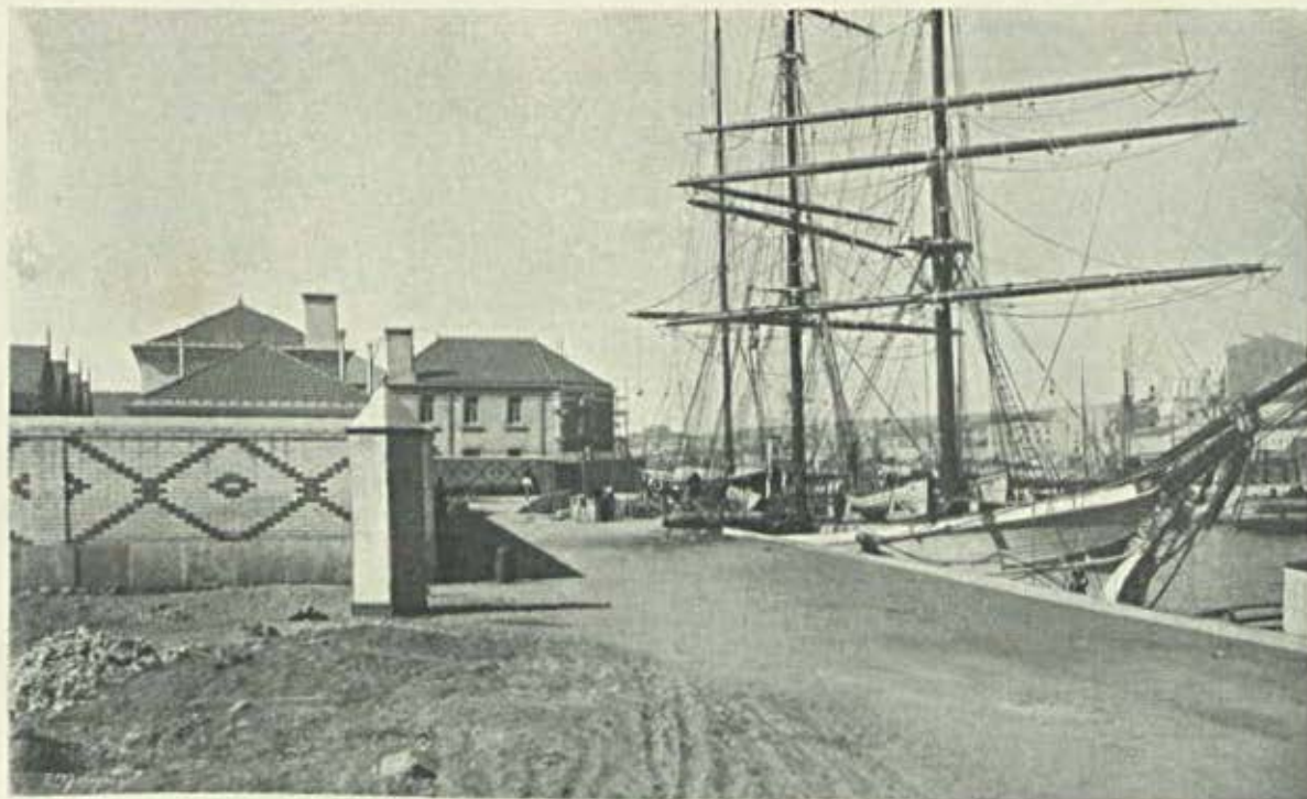
Posto de desinfeção. — Vista lateral. — Caes de acostagem
