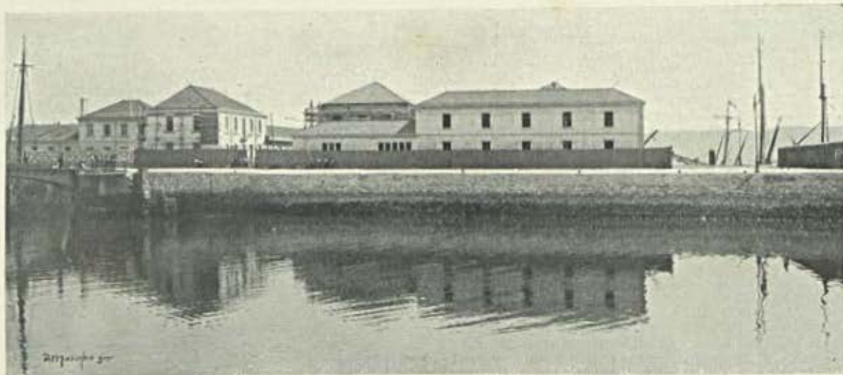
Posto de desinfeção. — Vista do lado de terra
