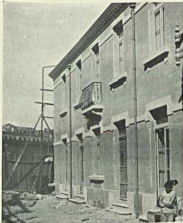
Posto de desinfeção. — Habitação para empregado do posto
