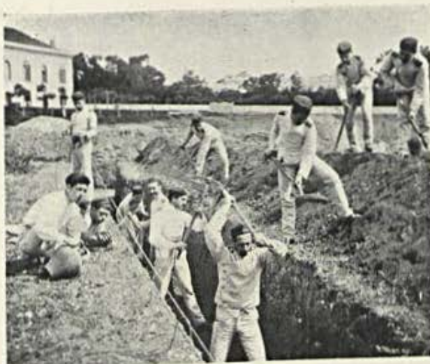
Escola do Exercito. — Trabalhos de sapadores
