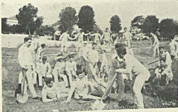
Trabalhos de sapadores
