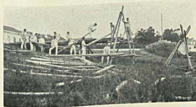
Construção de uma ponte
