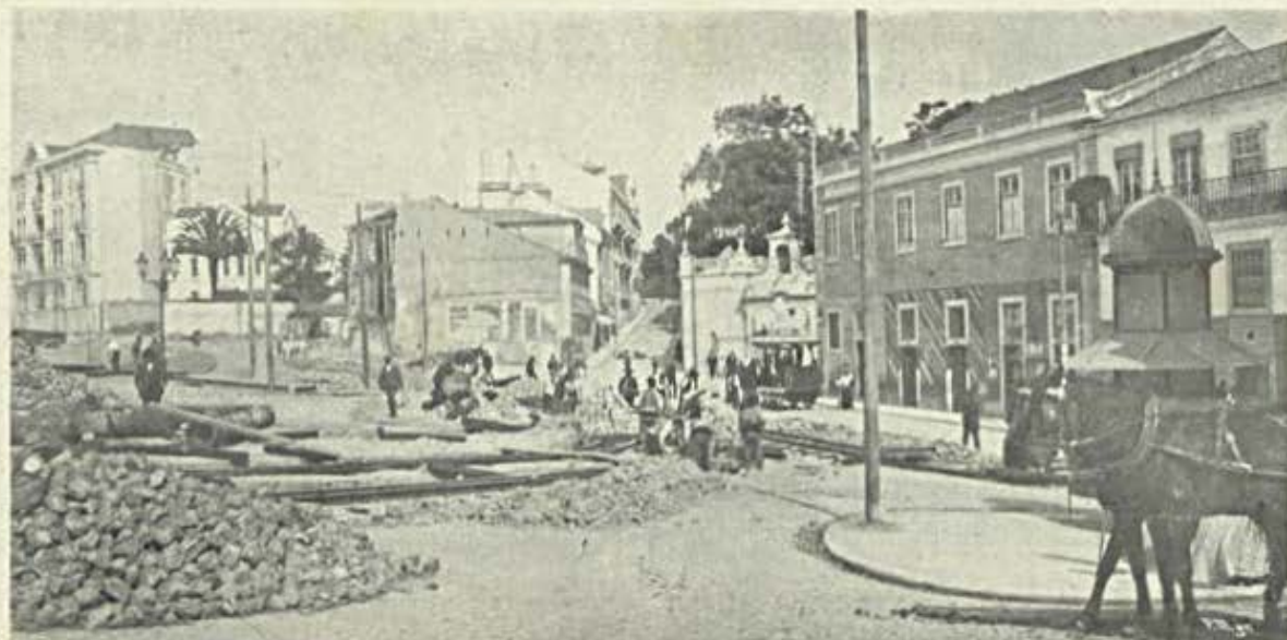
LISBOA NOVA. — O largo do Rato. — Os trabalhos para a tracção electrica
