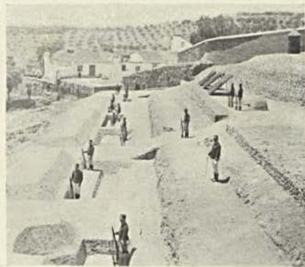
Obras dos sapadores
