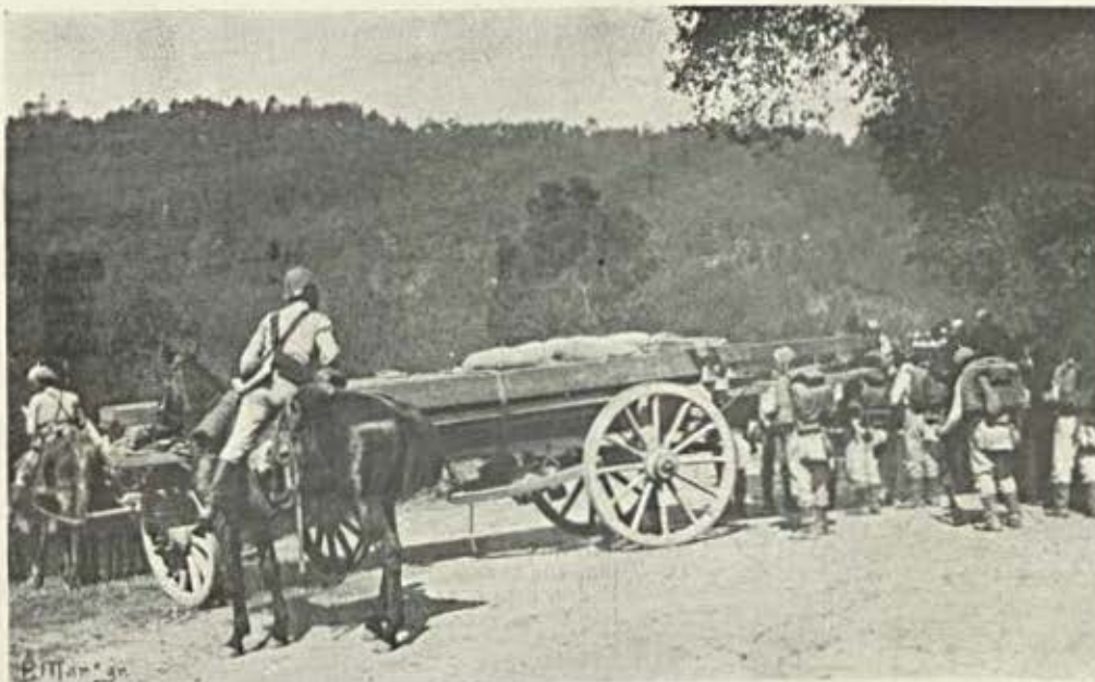
Nas margens do Criz. — Viatura de engenharia com material para a ponte
