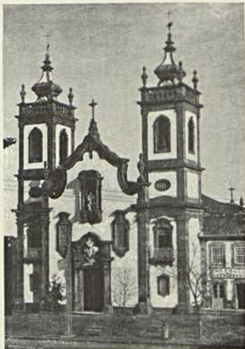
Guarda. — Igreja da Misericórdia
