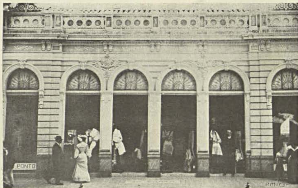
Fachada do edificio
