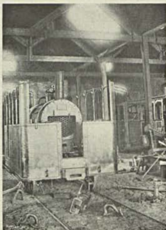
Montagem de uma caldeira
