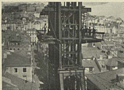
A ponte e o pilar no momento de começar a manobra
