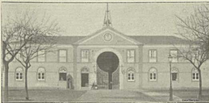
Edifício do Matadouro
