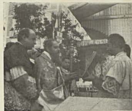
O Bispo do Porto lançando a bênção á primeira pedra da nova Estação Central do Porto
