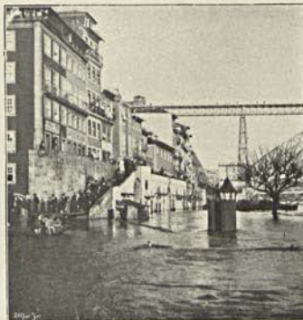
A inundaçáo no caes da Ribeira
