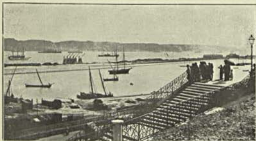
A esquadra ingleza vista da Rocha do Conde de Olibões
