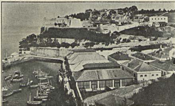
Vista geral do Lazareto (lado ponte)
