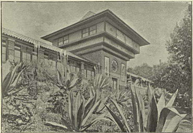
Deposito - visto de frente
