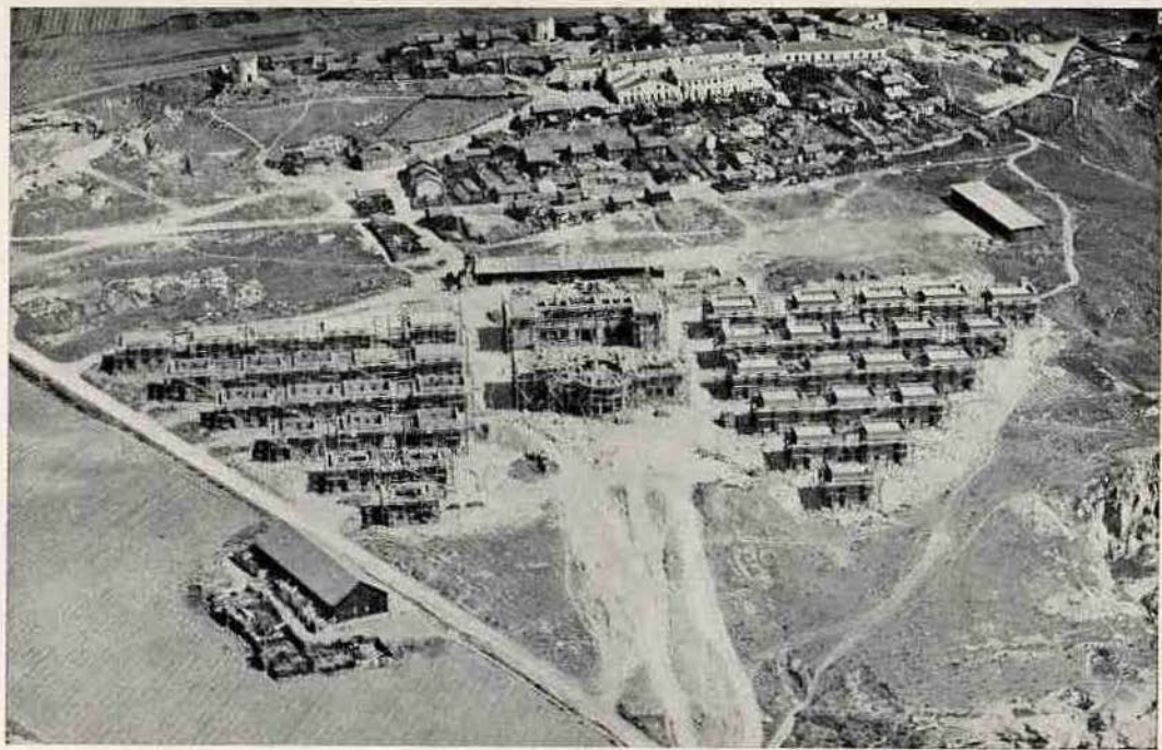
Aspecto do Bairro de Casas Econômicas, em construção, pertencente à Caixa de Socorros
