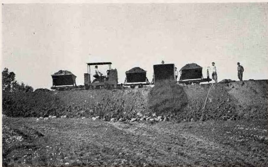
Trabalhos de terraplenagem em curso para a construção do Novo Matadouro
