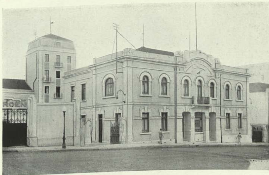
Batalhão de Sapadores Bombeiros — Quartel da Avenida Defensores de Chaves (5. a Companhia)
