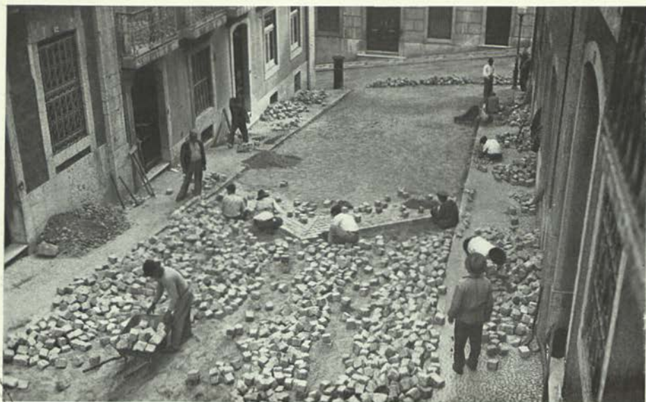
Um aspecto de pavimentação a blocos de granito da Rua da Emenda
