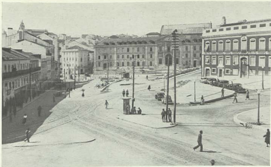
Obras de urbanização resultantes da ampliação da Praça do Brasil
