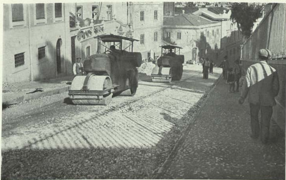
Um aspecto da pavimentação da Rua do Quelhas — Trabalhos de cilindragem do macadame
