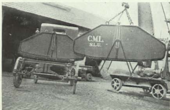
Descarga das caixas
