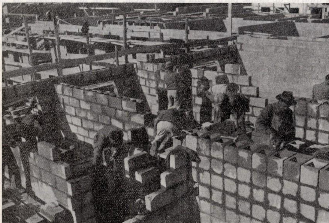
Fig. 3 — Casas de renda económica — Execução de alvenarias de blocos de betão.
