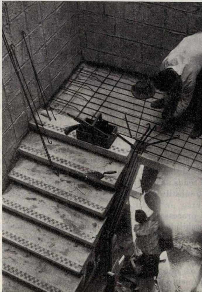
Fig. 5 — Casas de renda económica — Degraus de betão, prèfabricados.
