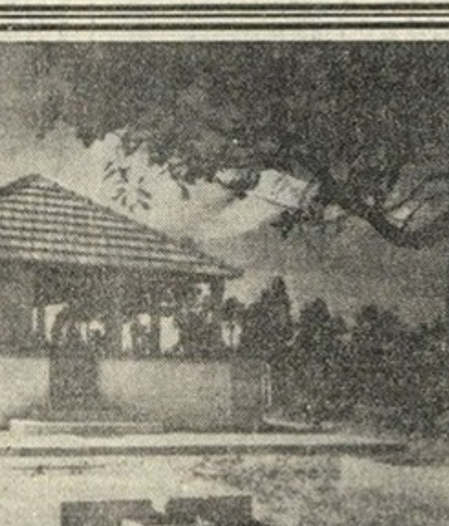
Para celebrar a data memorável da inauguração da PONTE SALAZAR sobre o Tejo, a Capela da Quinta de N. S. de FATIMA, sítio no ALTO DO MOINHO, em CORROIOS, está patente ao público que a queira visitar, nos dias 6 e 7.
