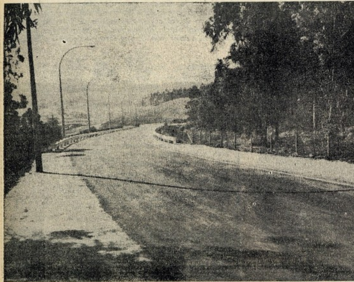
Uma derivação que parte da auto-estrada para os acessos à ponte que liga Campolide à Estação Marítima de Alcântara
