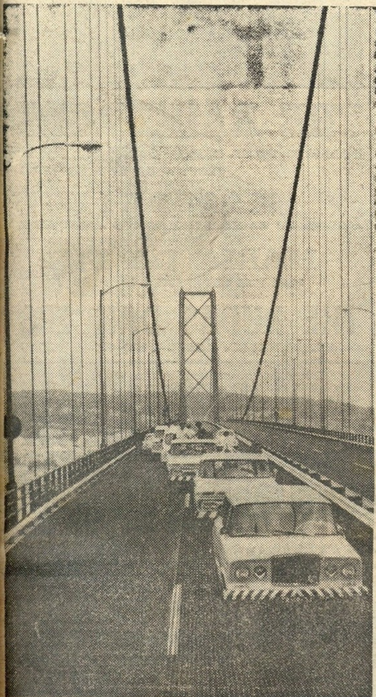
Sobre a ponte já circularam hoje os veículos destinados a serviço do público, entre os quais se contam uma ambulância e vários prontos-socorros, na prevenção de todos os tipos de acidentes que possam ali ocorrer
