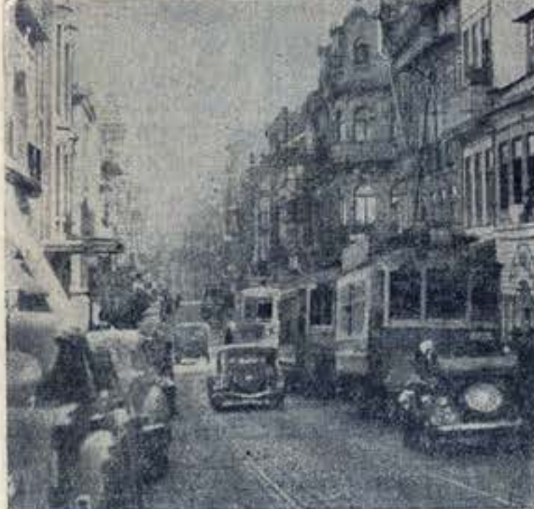
Na Rua de Santa Catarina, observa-se sentido único desde a Batalha até Gonçalo Cristóvão
