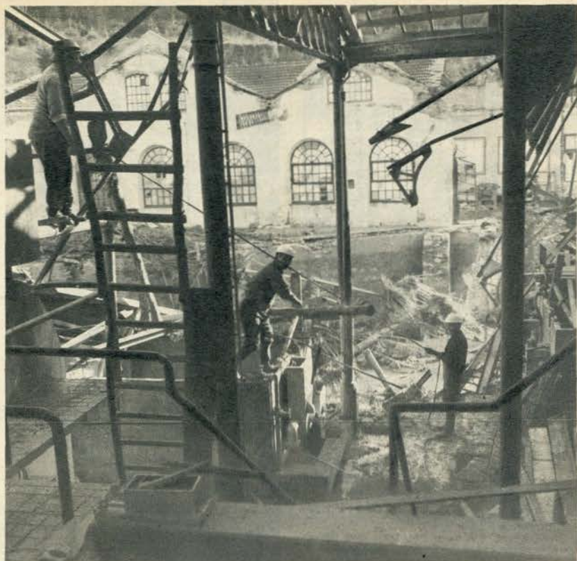
As obras de reconstrução da fábrica de papel de Alenquer começaram já
