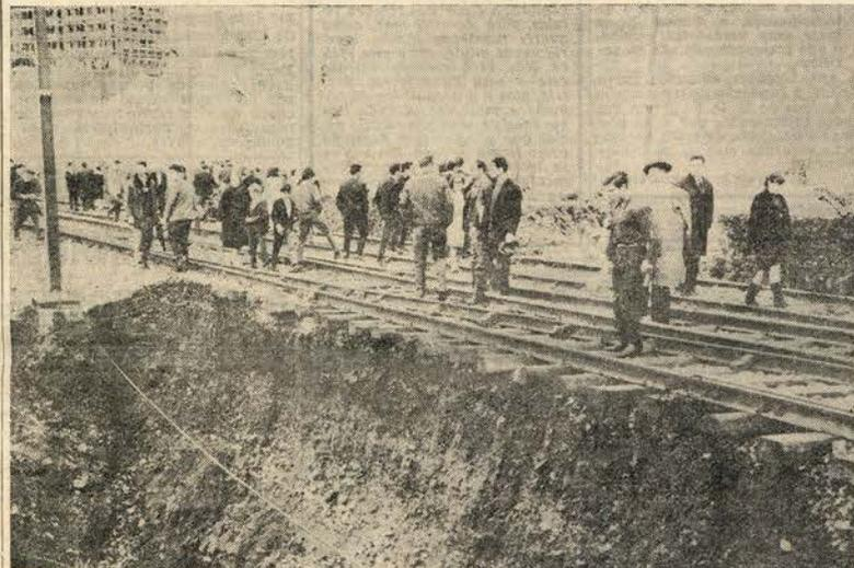
Alinhamento de terras próximo da estação de Queluz. O balastro, levantado pela enxurrada, obstruiu a via férrea. O comboio deixou de circular.
