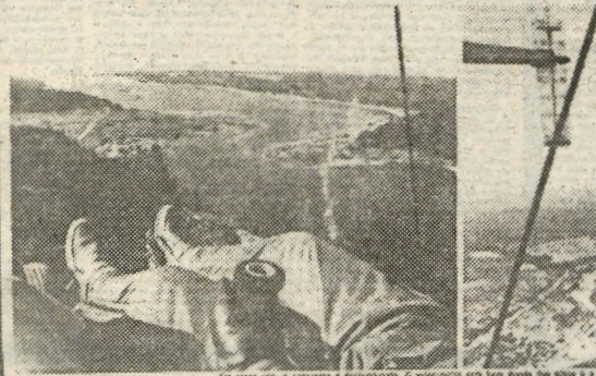
Um passo vital, o pilotagem e desmontagem. O equipamento está sendo montado em duas partes e a montagem é feita em etapas
