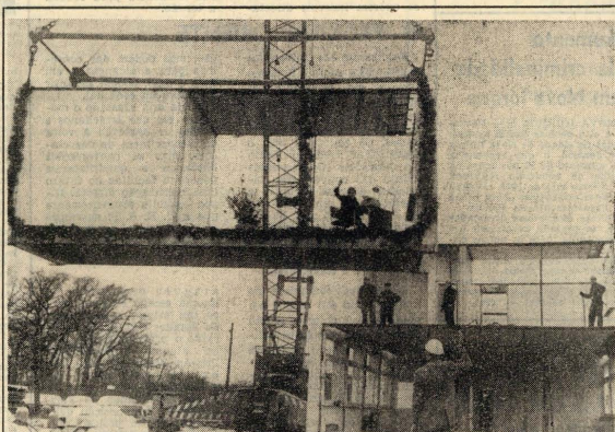
Parece estar a impor-se, definitivamente, a construção de edifícios pelo recurso a elementos ou módulos pré-fabricados. O processo tem, como principal vantagem, uma notável economia de tempo e de dinheiro. Aqui vemos, suspenso de um grua, um apartamento completo, a ser colocado no local que lhe compete num edifício ora construído em Hamburgo.
