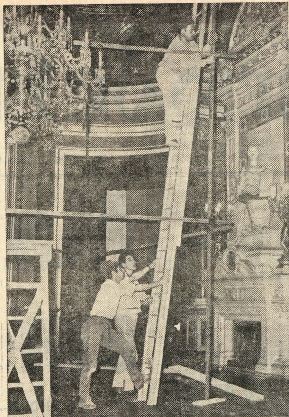
Operários restauram os estragos provocados pelo sismo de sexta-feira no salão de visitas dos Paços do Concelho
