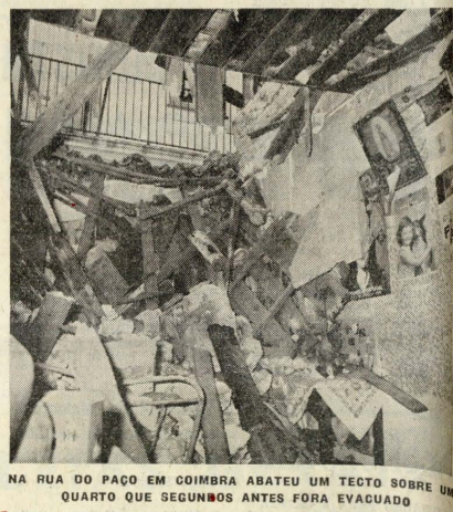
NA RUA DO PAÇO EM COIMBRA ABATEU UM TECTO SOBRE UM QUARTO QUE SEGUNBOS ANTES FORA EVACUADO
