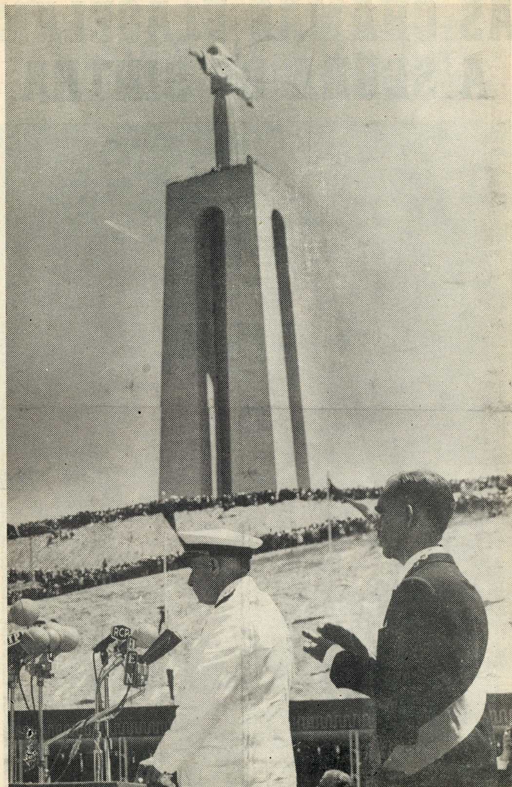
As 12 e 55, precisamente, o sr. Presidente da República, accionando um comando a distância, inaugurou simbolicamente o grande melhoramento da Ponte Salazar. A seu lado, o sr. ministro das Obras Públicas testemunha o momento culminante da solene cerimónia
