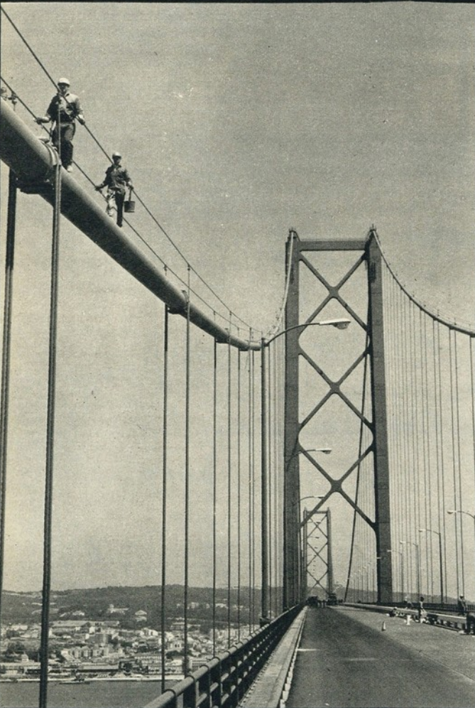
JÁ CONCLUÍDA A PONTE AINDA PRECISA DE UM OU OUTRO RETOQUE
