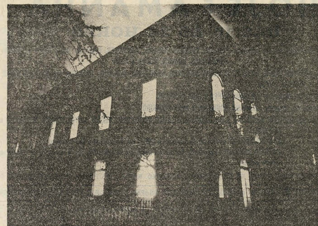
Em plena noite, o volume e intensidade da chamas destacam-se nas janelas do edifício
