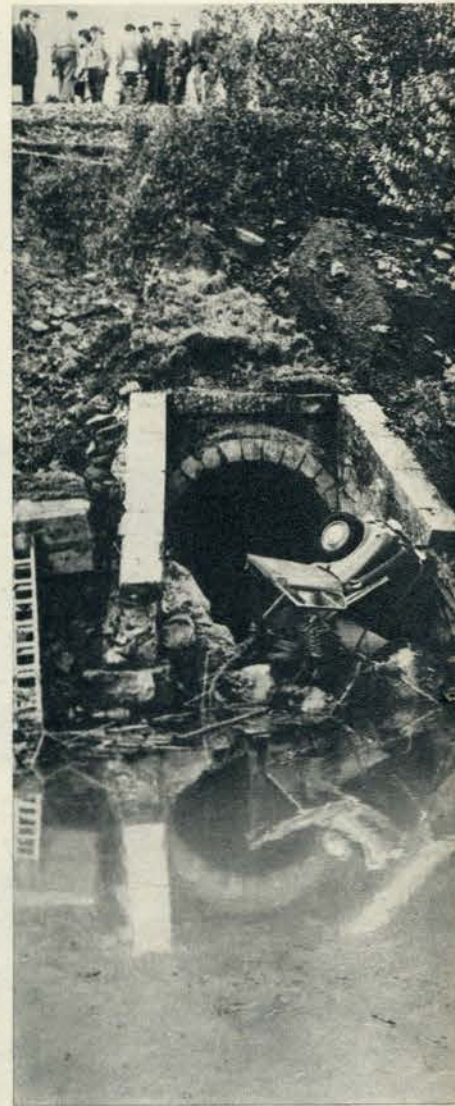
A estrada (Queluz) abateu. No fundo da ravina, o carro é agora um destroço, alvo não já de admiração mas somente de comiseração. E muitos foram os que tiveram fim semelhante na tragédia fora de portas.
