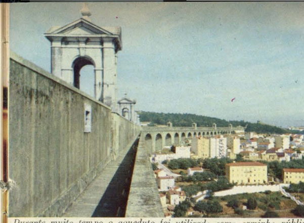
Durante muito tempo o aqueduto foi utilizado como caminho público.
