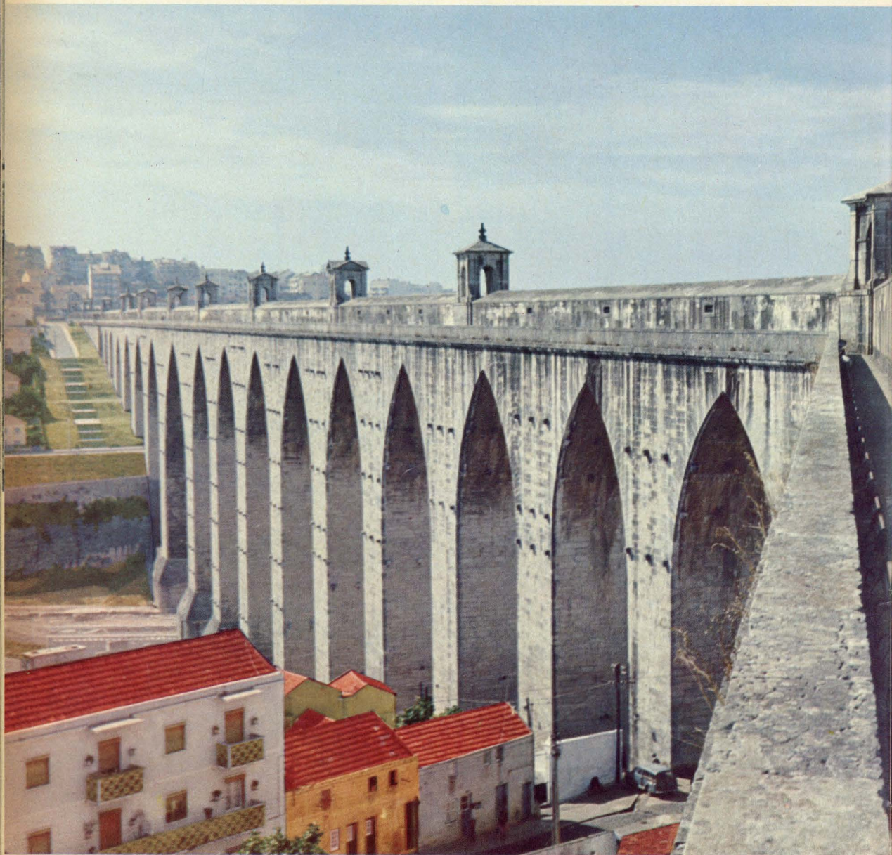
O aqueduto atravessa o Vale de Alcântara sobre 35 arcos, numa extensão de 942 metros, sendo 14 góticos e os restantes circulares. Cada um dos torreões
